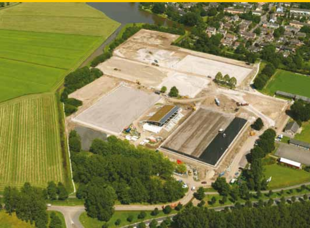
De bouwwerkzaamheden van bovenaf gezien.
