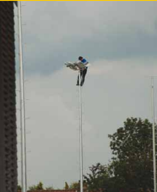
De led-verlichting wordt geïnstalleerd.
