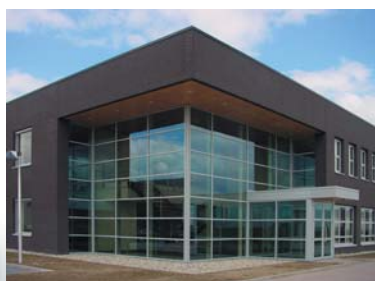
Beelden van de recent gerealiseerde nieuwbouw van TRANSFERRO, bedrijventerrein Hessenpoort, Zwolle
